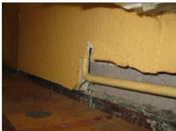
Innendämmung mittels Polystyrol-Platten
