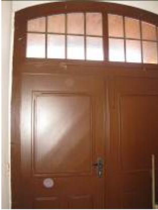
Fehlendes Dichtungsprofil Eingangstür
