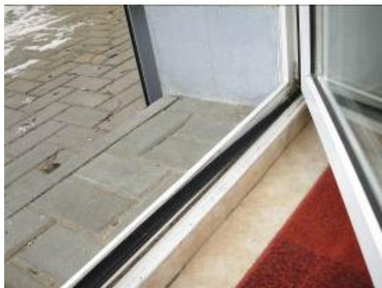
Defektes Dichtungsprofil „Hr. Nilson-Raum“
