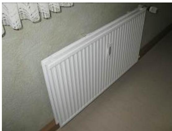
Wärmeübergabe durch Plattenheizkörper
