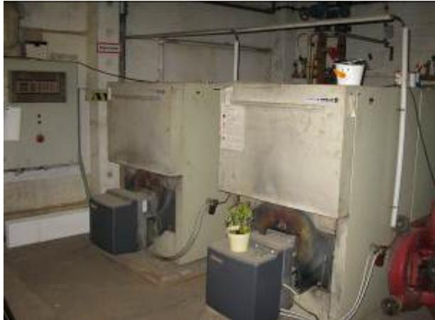
Heizungsanlage, im Vordergrund die zwei ausgetauschten Brenner
