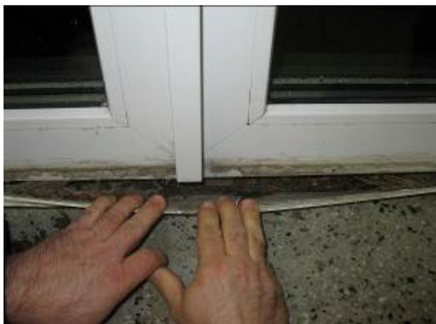
Schäden an Fenstern durch Mauersegler
