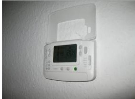
Innenraumtemperaturregler für Ventilator-konvektoren
