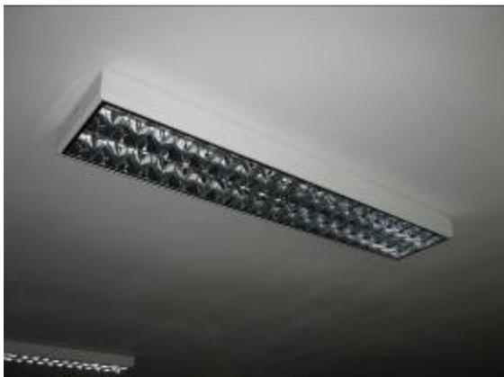
Leuchtstoffröhren in Spiegelrastergehäuse (gute Ausleuchtung durch spiegelrasterung)
