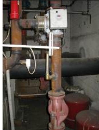
Keinerlei Isolierung der Heizungsrohrleitungen vorhanden
