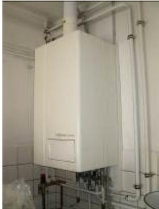
Viessmann Pendola Gas-Brennwertgerät
