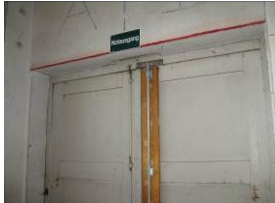
Keine Dichtungsprofil an Außentüren
