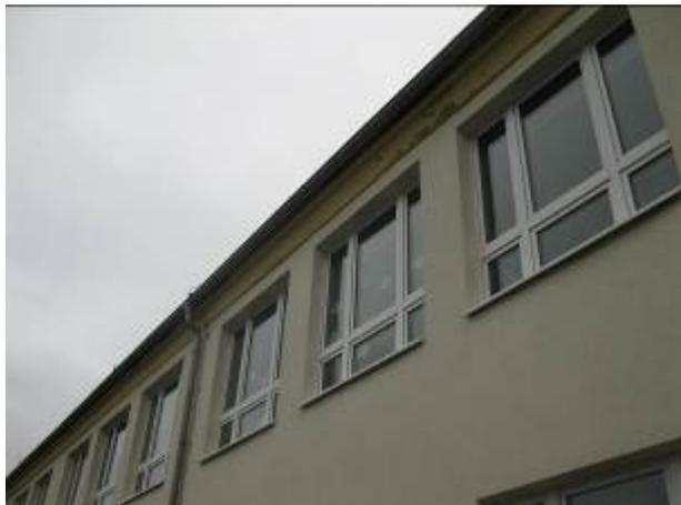
Abbröckelnder Putz unter der Dachkante
