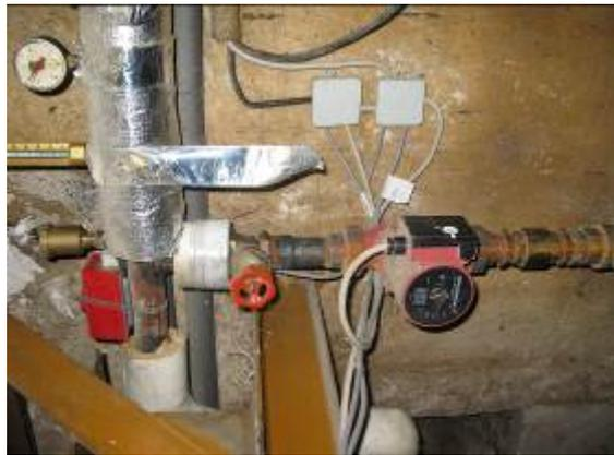
Mangelnde Isolierung von Heizungsrohrleitungen
