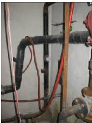
Keine Isolierung an Heizungsrohrleitungen
