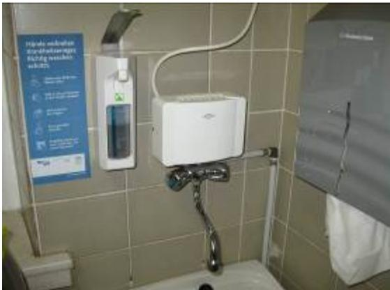
Elektrischer Durchlauferhitzer im Sanitärbereich
