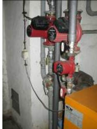
Mangelhafte Isolierung der Rohrleitungen
