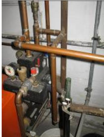
Mangelhafte Isolierung der Heizungsrohre
