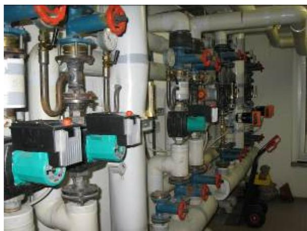
Unvollständig isolierte Heizungsrohrleitungen
