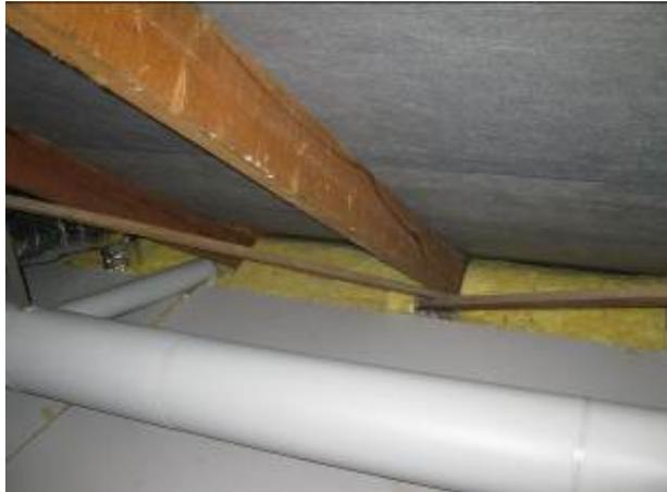
Dämmung der obersten Geschosdecke bzw. des Bodens des Dachgeschosses
