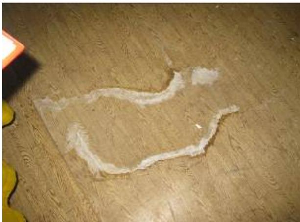
Spuren eindringenden Wassers auf dem Dachboden
