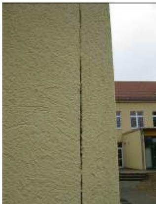
Fassadendämmung Kitabereich, noch zu verschließender Spalt
