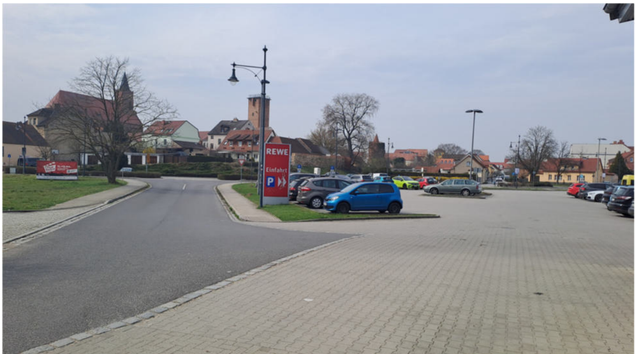
Abbildung: Hauptzufahrt zum REWE-Markt im Bestand mit Einmündung Erschließungs-Zufahrt zum Wohngebiet „Zur kleinen Schleuse“ am linken Bildrand
