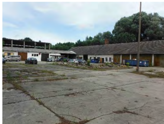
Abbildung 18: Betonierte Innenhofbereiche mit Parkplätzen (Stadt Land Brehm, Juli 2024)
